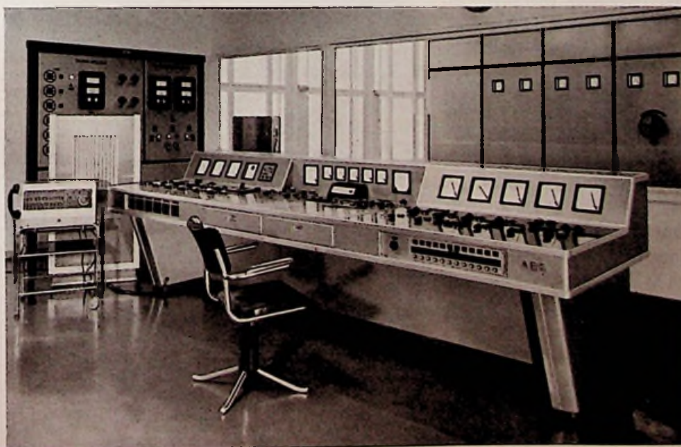
Bild 4: Bedienungsraum für den 300-kW-Rundfunksender RIAS Berlin.
