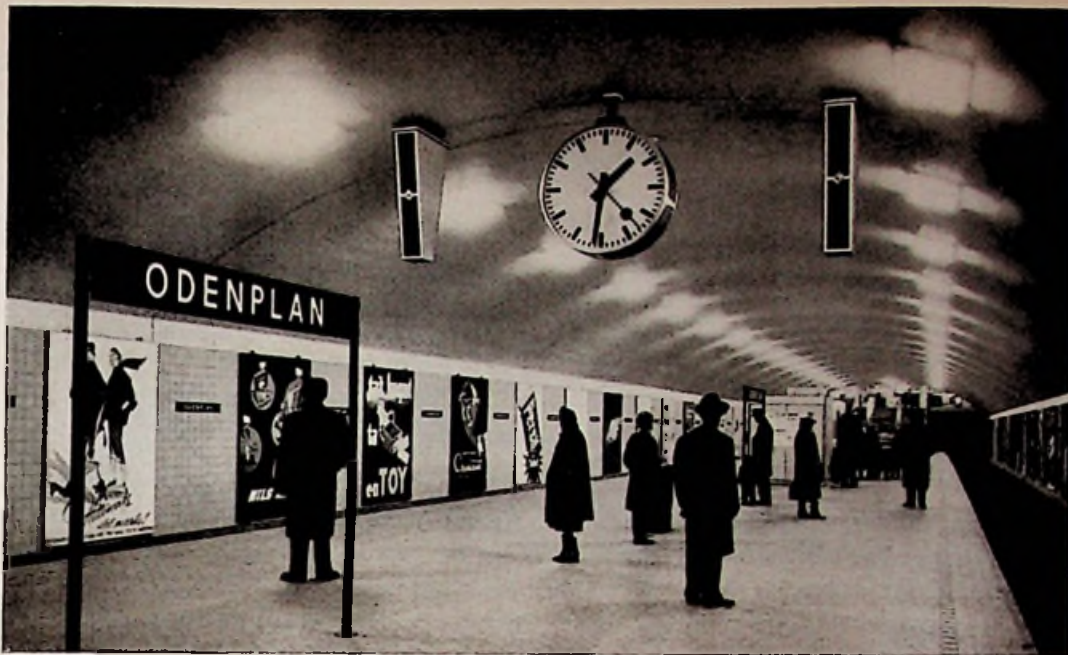
Bild 7: Lautsprecher-Anlage in der Station Odenplan der U-Bahn Stockholm.
