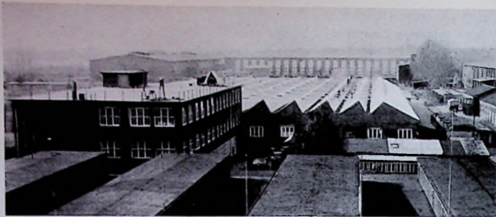
Bild 4: Telefunkenwerk Hannover. Blick vom Verwaltungsgebäude auf den Verbindungsbau. Dahinter die Halle II, im Vordergrund das Dach der Halle I.
