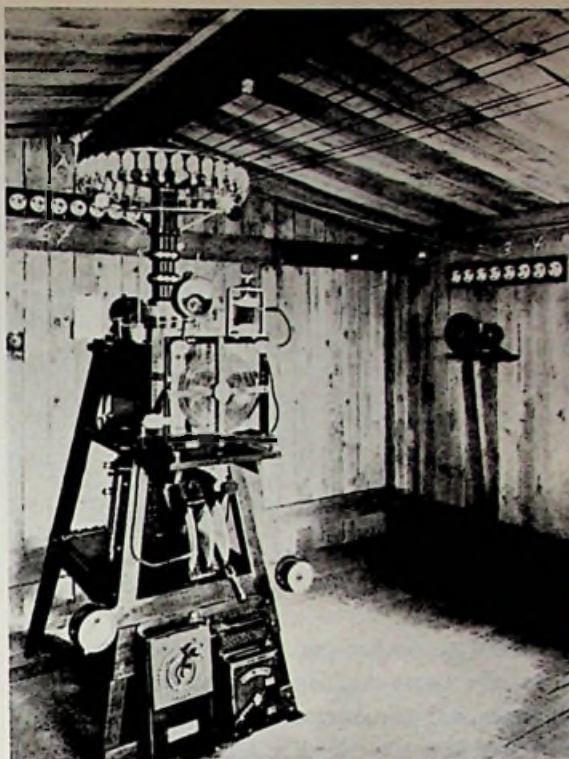
Bild 1: Löschkundensender für den Telefunkenkompaß A. Meißner (1907).
