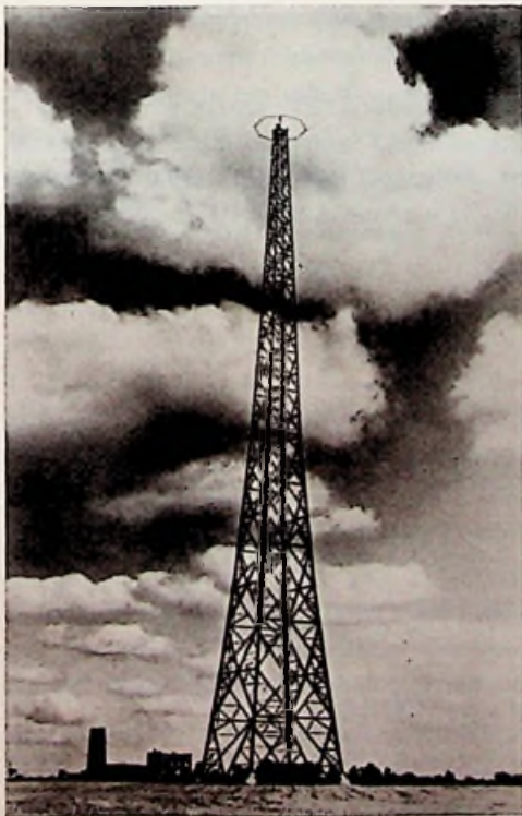
Bild 12: Schwundmindernde Vertikalantenne im Holzturm beim Rundfunksender Breslau (1933).
