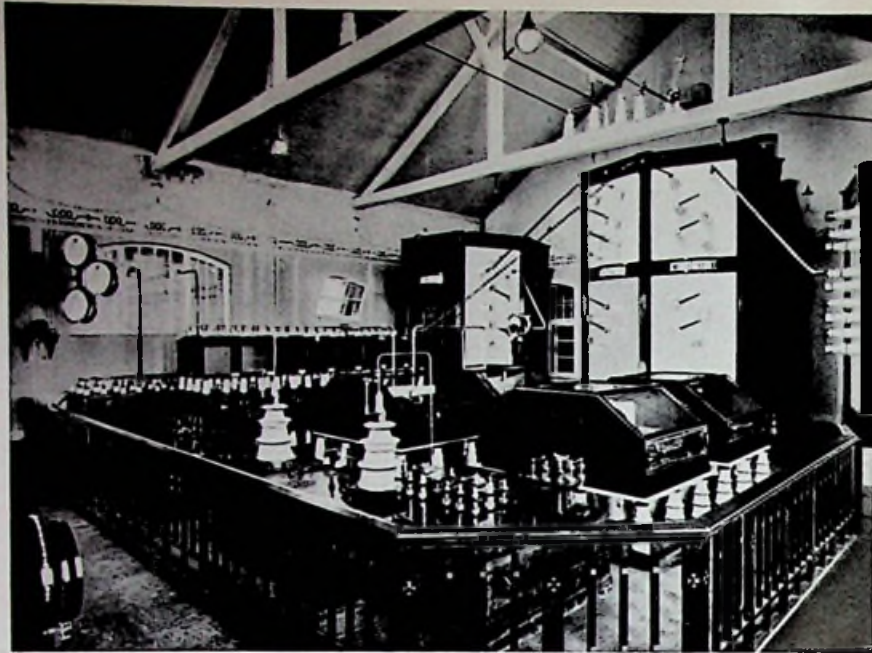
Bild 12: 100-kW-Löschfunksender in Nauen (1912).
