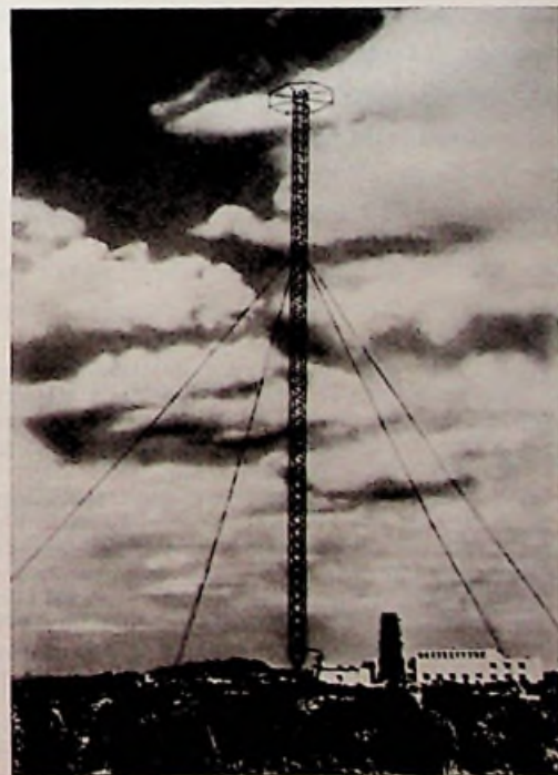
Bild 13: Selbstschwingender Mast mit Schwundminderung beim Rundfunksender Hörby (1937).
