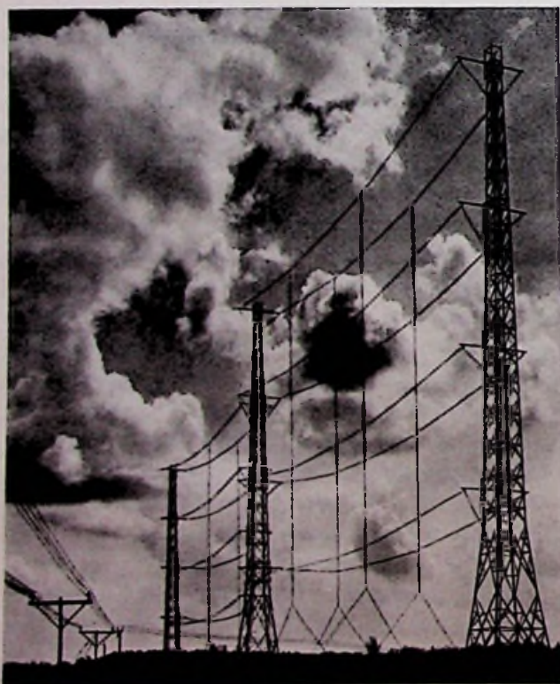
Bild 2: Telefunken-„Tannenbaum“-Antenne auf der Funkstelle Nauen (1928).
