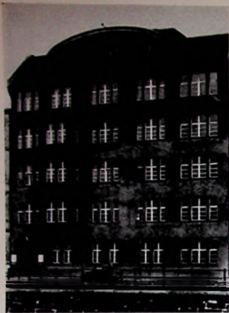
Das ehemalige Laboratoriumsgebäude Berlin, Tempelhofer Ufer. Zur Zeit ist in ihm nur die Lichtbildstelle von Telefunken untergebracht.
