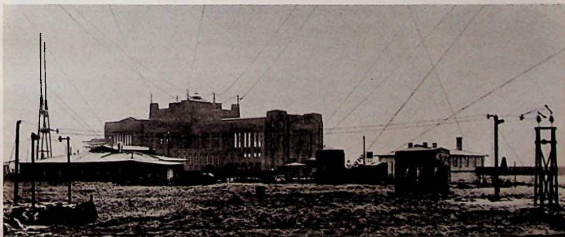
Bild 5: Betriebsgebäude Nauen, Stand 1924. Im Vordergrund eine Zuleitungsverkürzung für Kurzwellen-Richtantennen.
