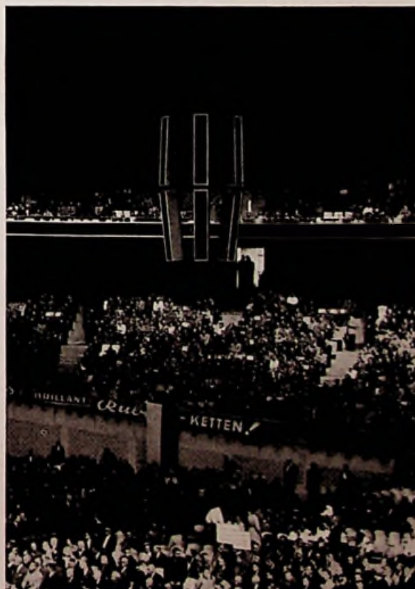
Bild 4: Zentrale Beschallung der 22000 Personen fassenden Westfalenhalle in Dortmund durch eine Telefunken-Anlage mit Tonkorb.
